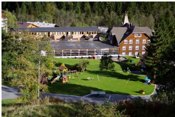
Das Romantikhus mit daran anschließendem Gemeindezentrum und Veranstaltungssaal.
