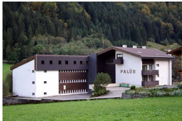
Appartementhäuser bilden mitunter Fremdkörper im Siedlungsbild und in der Siedlungsstruktur.
