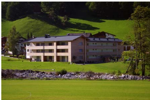
Die Zweitwohnungen weisen eine sehr geringe Auslastung auf. Geschlossene Fensterläden und schmucklose Balkone prägen die Fassaden.
